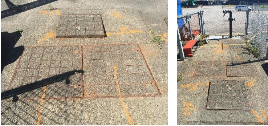
Eerder geïnstalleerde zware betonnen afdichtingen
