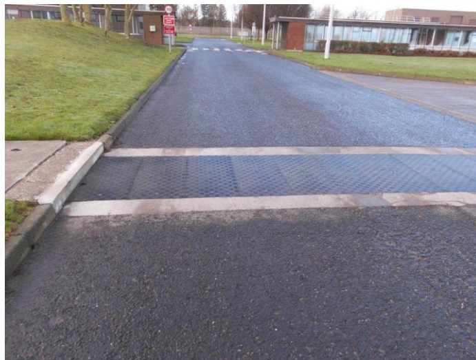
Fibrelite Trench Covers geïnstalleerd bij farmaceutisch bedrijf in Northumberland, UK
